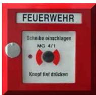
Neben den automatisch wirkenden Brandmeldern sind in Gebäuden **mit Brandmeldeanlage** in den Fluren und Treppenhäusern **manuell zu betätigende Feuermelder** zu finden. Sollte der automatische Alarm im Brandfall noch nicht ertönen, kann mit dem Betätigen des Druckknopfes der Alarm ausgelöst werden. Dazu ist die Schutzscheibe mit einem Gegenstand oder dem Ellbogen einzudrücken.
